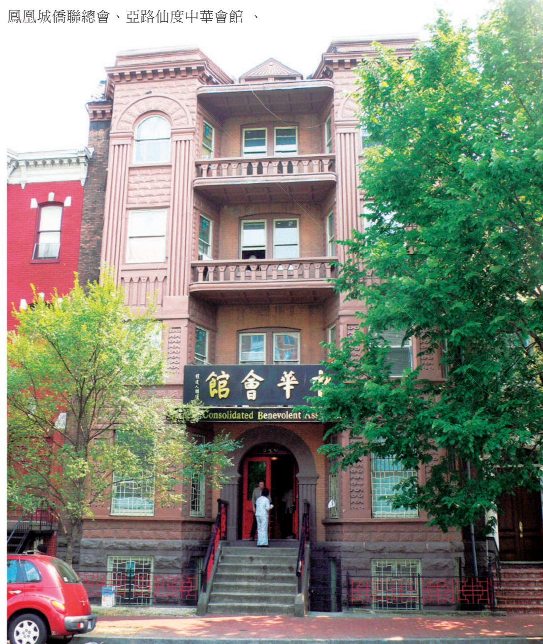
攝於 2007 年之美京中華會館舊觀，2015 年初火災後修復中。
